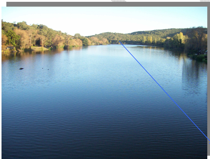
Paredón del dique La Falda
